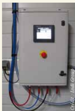
L'automate pilote les postes de nébulisation
